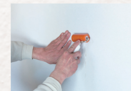
継ぎ目の部分は壁紙用ローラーを使用。
